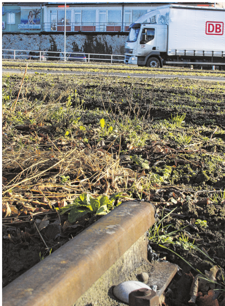
Hier wird kein Zug mehr fahren: An der Ehlersstraße in Friedrichshafen ist das Industrie Gleis durchtrennt. Es war dem Bau eines Kreisverkehrs im Weg. Im Hintergrund ein Lastwagen mit dem Logo der Deutschen Bahn – Symbol für die Verlagerung des Güterverkehrs auf die Straße. BILD: LÖFFELHOLZ
